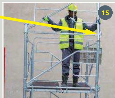
Emboîtement avec verrouillage automatique Tube joints with automatic lock
