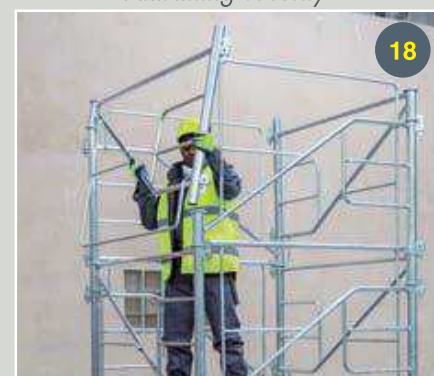
Fixation du planchon avec système anti soulèvement Anti-lifting security
